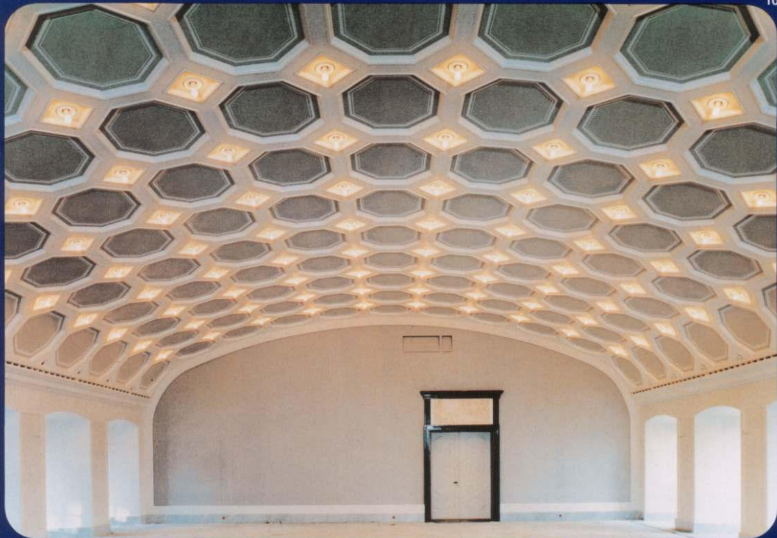
Deutsche Bank, Düsseldorf, Königsallee · Kassetten und indirektes Beleuchtungsgesims sind Sonderanfertigungen.
